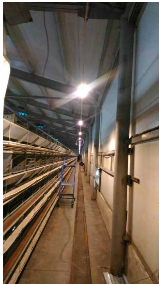
Фото 2 – Светодиодное освещение в птичнике родительского стада размерами 18x79. Расстояние между светильниками 1,8 метра
